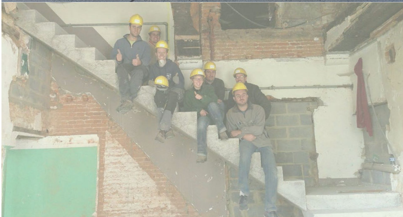
2023 : Rénovation du porche d'entrée
